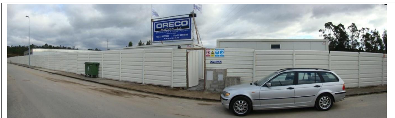
Figura 5.115: Fachada do Projecto virada a NW
