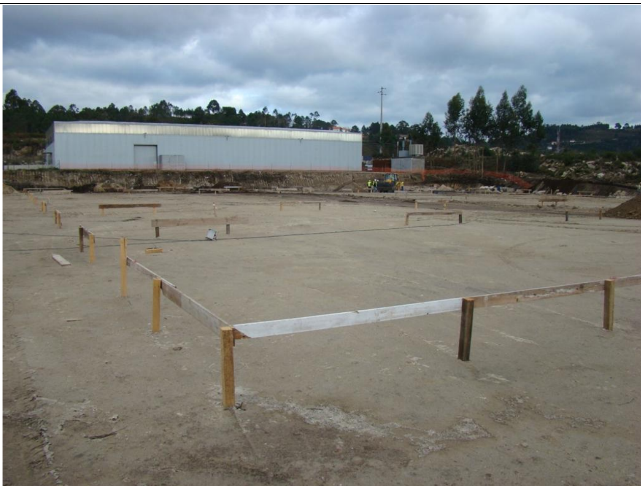
Figura 5.54: Aspecto da plataforma onde o Projecto vai ser construído (Fevereiro de 2012)
