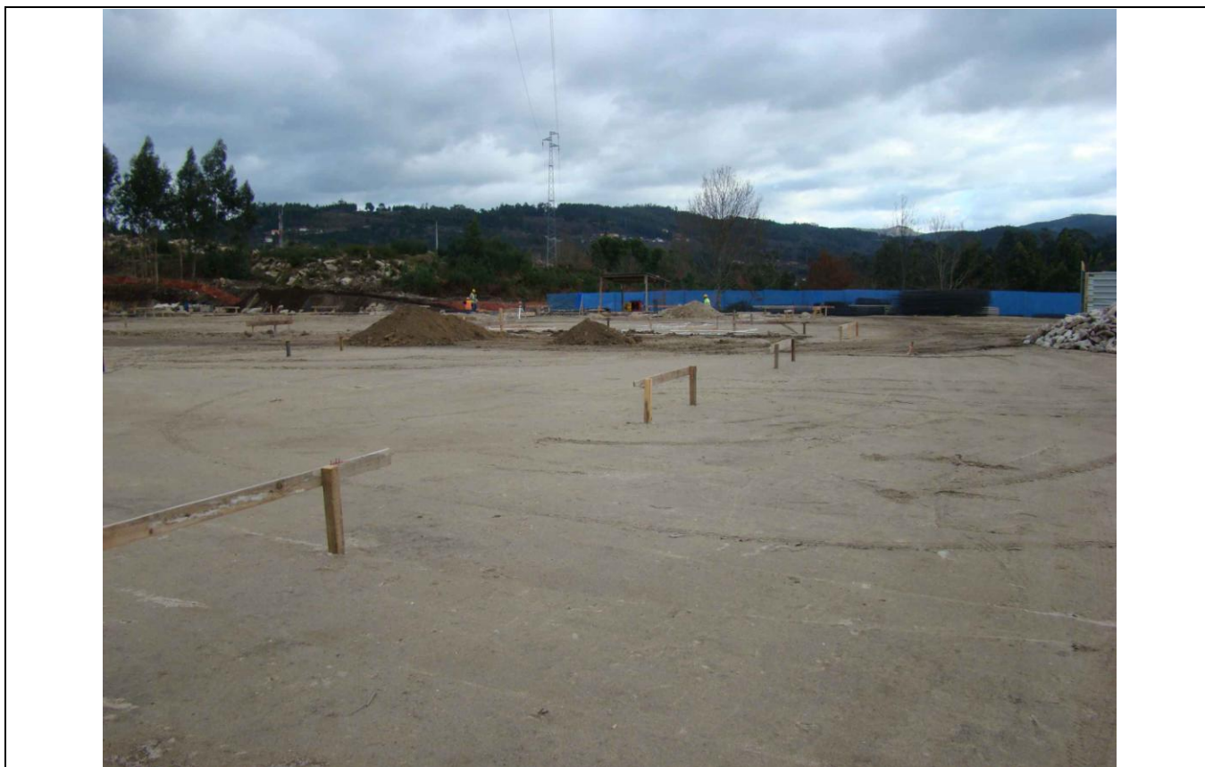
Figura 5.39: Aspecto da plataforma onde o Projecto vai ser construído (Fevereiro de 2012)
